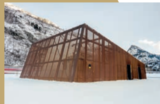
Neubau Unterwerk (UW), Glis BAUATELIER12/AFRY Schweiz AG
