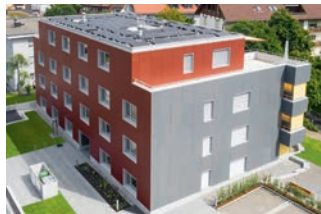
PlusEnergie Mehrfamilienhaus, Affoltern am Albis Viridén + Partner AG
