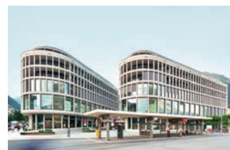
Neubau Steinbock, Chur GIUBBINI ARCHITEKTEN ETH SIA AG
