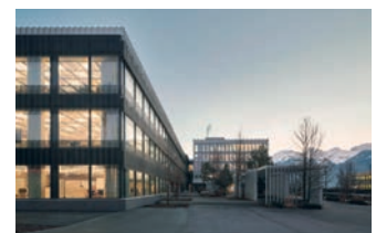
Bürohaus Office Mitte Hilti, Schaan Giuliani Hönger Architekten ETH BSA SIA
