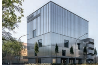
Probehaus Luzerner Sinfonieorchester, Luzern Enzmann Fischer & Büro Konstrukt AG
