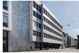
St. Leonhard-Strasse 7, St. Gallen K&L Architekten AG
