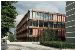
Hauptsitz Swissgrid, Aarau Schneider & Schneider Architekten ETH BSA SIA AG
