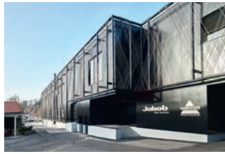
Jakob-Fabrikgebäude, Trubschachen Jakob Rope Systems
