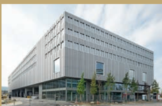
Logistikzentrum West-Log, Zürich Altstetten Felix Partner Architektur AG
