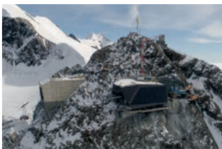
Bergstation 3S-Bahn - Klein Matterhorn, Zermatt Peak Architekten
